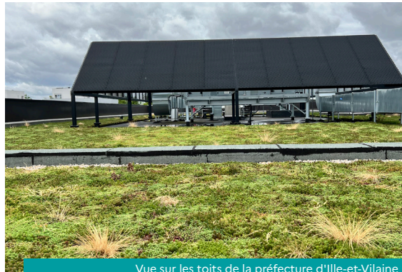
Vue sur les toits de la préfecture d'Ille-et-Vilaine
